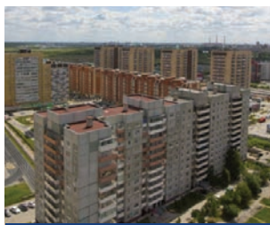
Детский сад, паркинг ЖК «РИВЬЕРА» г. Тюмень (ООО «Завод ЖБИ-5»)
