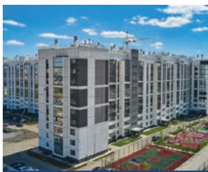
ЖК «ТЕРРИТОРИЯ» г. Челябинск (ООО «Специализированный застройщик «БМ-Групп»)
