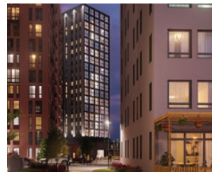
ЖК «Андерсен» г. Тюмень, ул. Полевая (ООО «Технический центр по теплогазоснабжению»)
