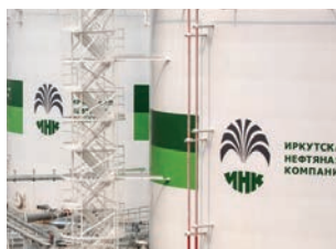
ООО «Иркутская Нефтяная Компания». Марковское НГКМ. Опорная база промысла
