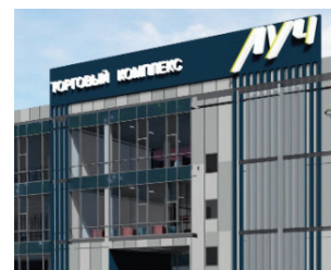
Торговый центр «ЛУЧ» г. Пермь
