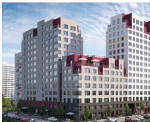
ЖК «Чемпионский» г. Тюмень (ООО «Технический центр по теплогазоснабжению»)
