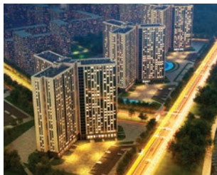
ЖК «ДОК» г. Тюмень ул. Ярославская (ООО «Технический центр по теплогазоснабжению»)
